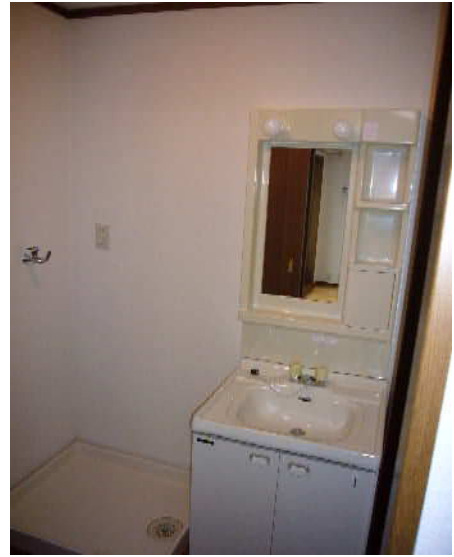
洗面台、洗濯機パン
